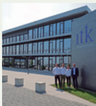
ITK Engineering GmbH. Inovativna poslovna zgrada u Nemačkoj. ECOi - PACi
